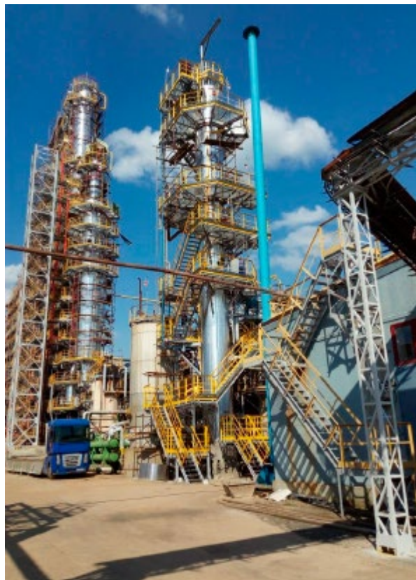
ООО «Киришинефтеоргсинтез» установка ГФУ
